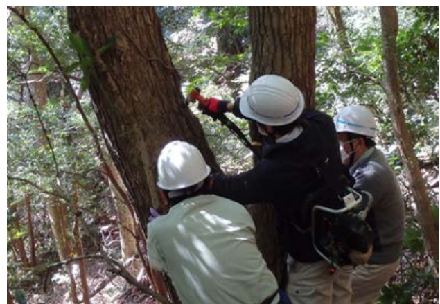
写真 2 エンジンドリルによる穴あけ作業
