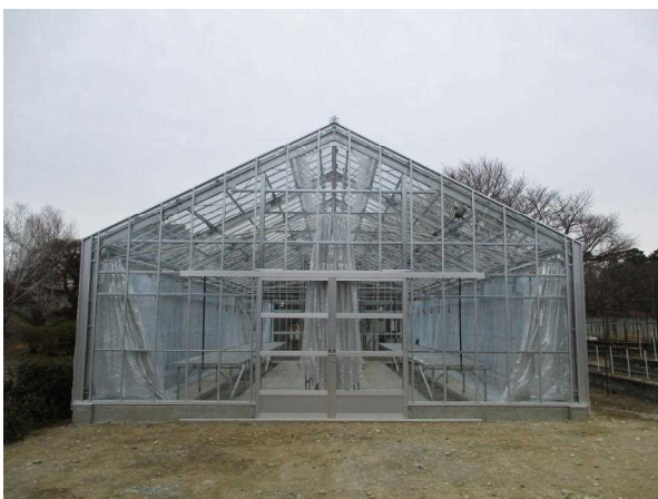
写真2 ガラス温室正面
