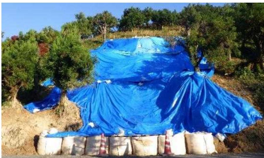
写真3 応急処置後の採種園斜面
