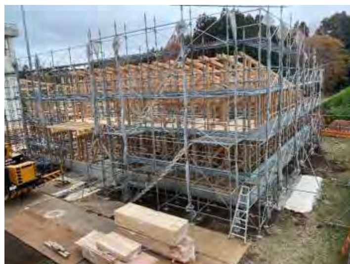
写真 着々と進む建築工事の様子（楽しみです）
