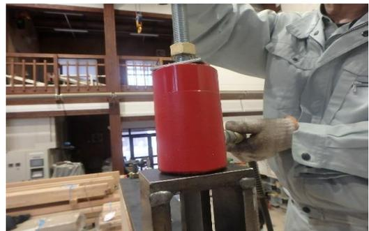
写真2 耐力壁にプレストレスを導入している様子
