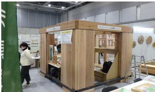
写真1 プレストレス技術を用いた木製耐震シェルター
