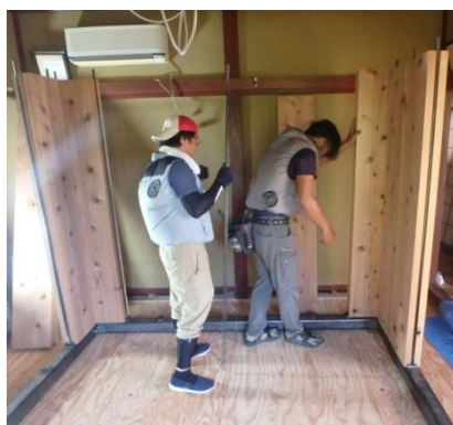
写真2 屋内での組み立て状況
