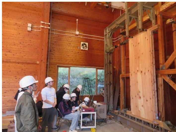
写真1 面内せん断試験の様子
