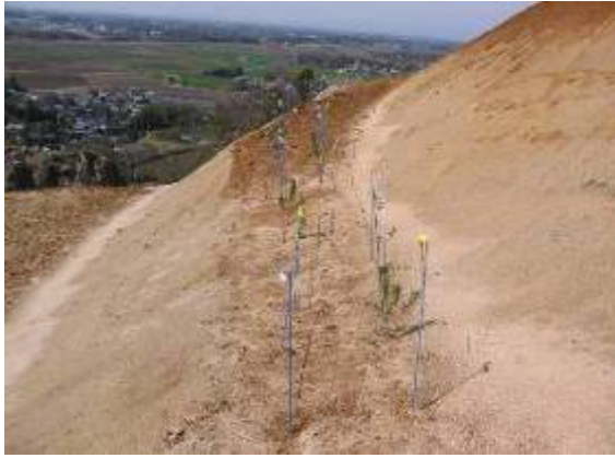
写真-1. のり面小段への苗木の植栽 (H16. 3)
