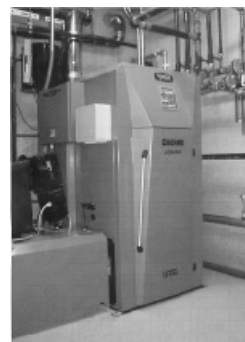
図 1. 導入したバイオマスボイラ熱利用システムの概要 写真 1. 導入したバイオマスボイラ
