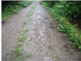
既設林道の路面水 (水は澄んでいる)
