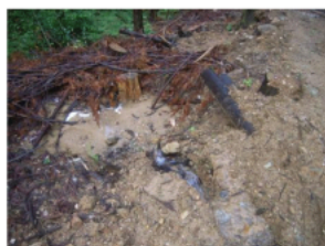
穴を掘り下部に枝葉を集積した 横断排水の流末 (細粒土砂が堆積)
