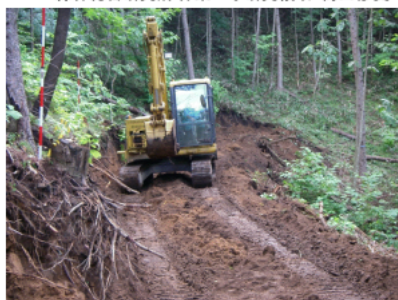
火山灰質粘性土（関東ローム）での作業路の作設（群馬県松井田）
