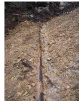
横断排水の状況
