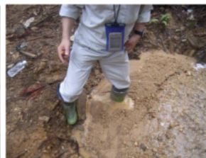
沈砂地 (堆積土の深さ30cm以上)
