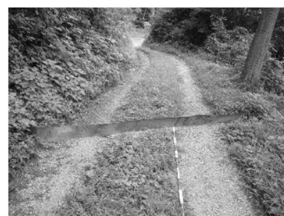
図 4 横断排水溝（ゴム製）
