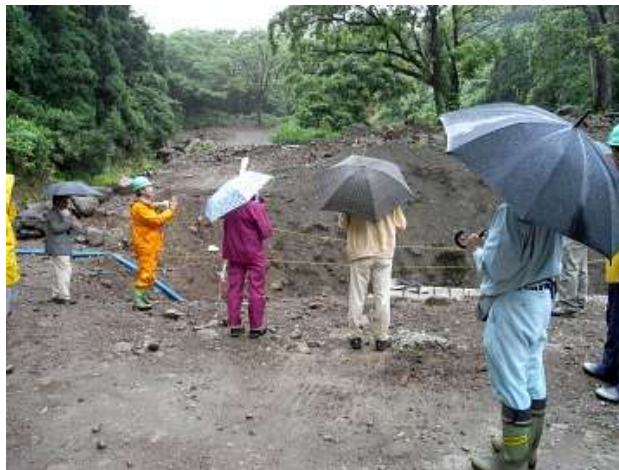
平成 22 年度現地検討会（富山県南砺市） 「豪雨災害による流木被害、および流木対策に配慮した災害復旧」太谷川流域
