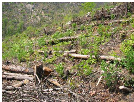
写真-1 簡易筋工
