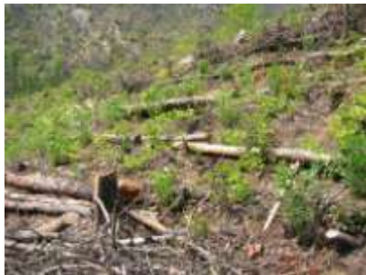
写真－1 簡易丸太筋工
