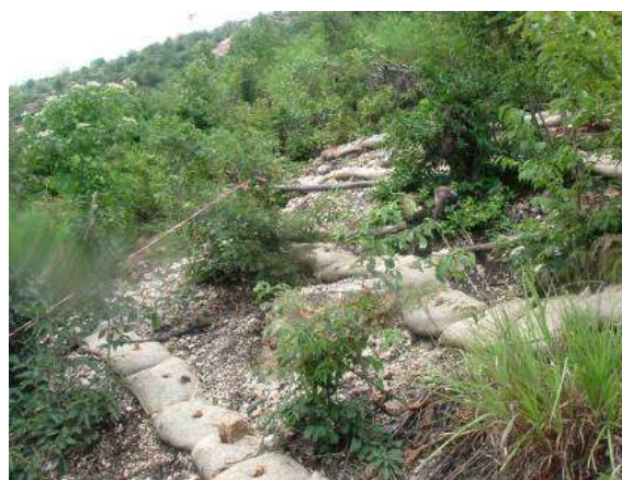
写真-2 植生土のう工
