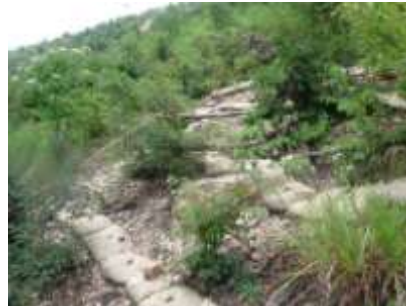
写真－2 植生土のう筋工
