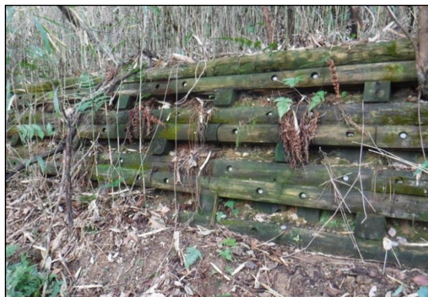
写真－1 ウッドブロック設置状況
