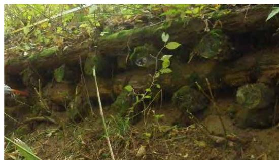
丸太部材の腐朽により、中詰め土が流出
