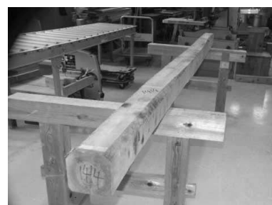
写真3 材面割れ無しの柱
