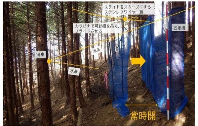
図-6 改良型ゲート設置状況
