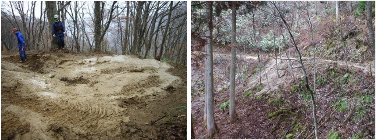
写真1 フォワーダ走行による作業路面の攪乱と林内への泥土の流出状況
