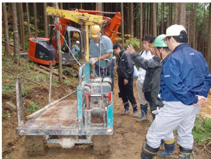
高密路網作業路での間伐材搬出作業
