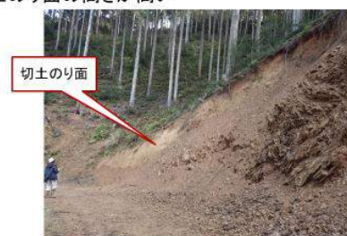
切土のり面が高いい箇所での崩壊の発生
