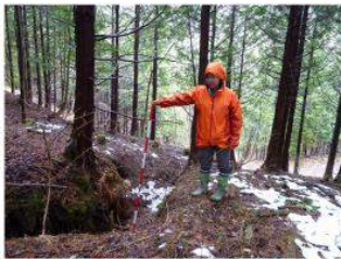
林道からの排水による林地斜面侵食の例
