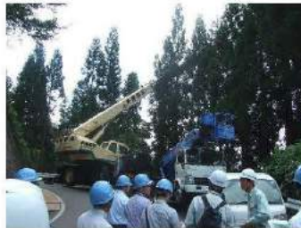
写真2 クレーン吊り搬出視察
