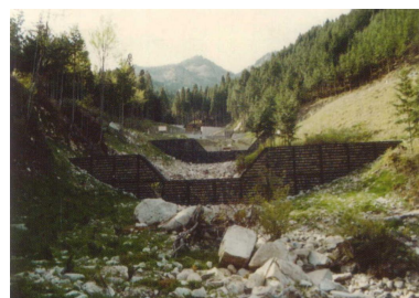
図2 浸透促進工の設置
