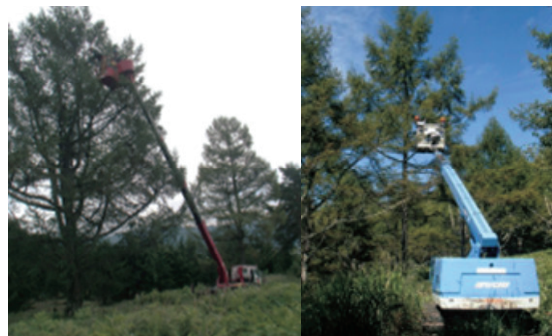
写真－１ 高所作業車による作業状況
