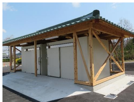
原種増産用冷蔵保存施設（令和7年3月新設）
