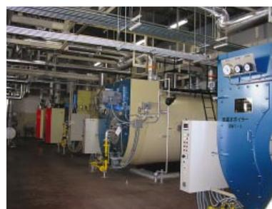
エネルギーセンター内の高温水ボイラー(手前)および蒸気ボイラー(奥)
