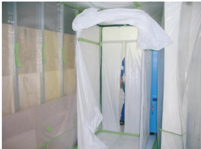
写真6 作業員の隔離区画内外への移動ゾーン。手前から前室、洗浄室、更衣室の3室構造になっている。右側の青色の装置がエアシャワーユニット。
