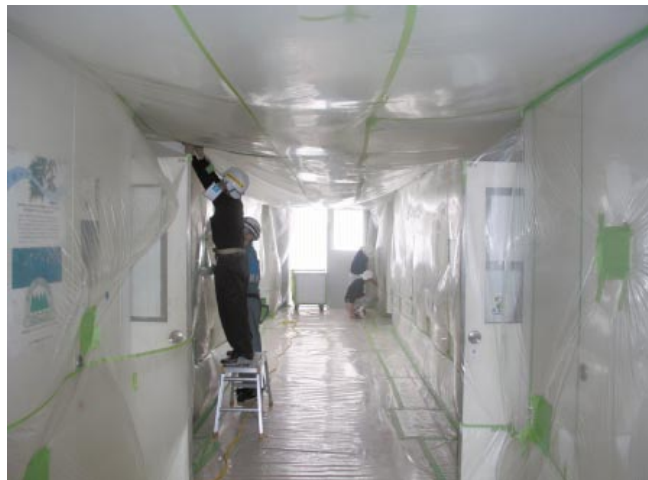
写真5 防護服を着用した作業員が出入りする廊下も密閉。
