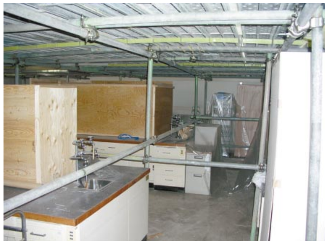
写真3 工事用足場を利用して、室内を工事区域の天井と区域外の床の2層に区分けし、実験機器や精密機械などを搬出後、実験台・家具類を養生。
