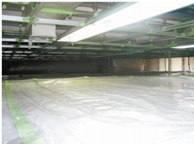
写真4 工事区域は粉じんが区域外に飛散しないよう密閉。
