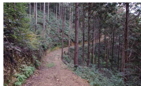
林内作業路の急傾斜地での施工例 切土は低く盛土は緑化されている
