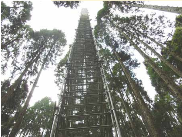
鹿北試験地の観測タワー
