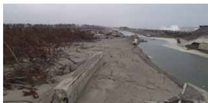
写真1 防潮堤の背後の洗掘と防潮堤の損壊
