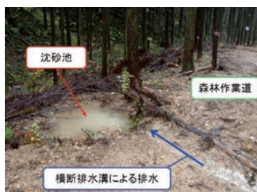
写真2 横断排水溝による表面流の分散排水と流末に設置された沈砂池
