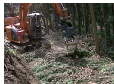
写真3 グラップルを用いて路面を枝葉で覆う作業
