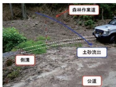
写真1 森林作業道から流出した土砂により公道の側溝が閉塞
