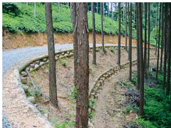
写真4 丸太組工法（のり留工）による作業道（広島県庄原市）
