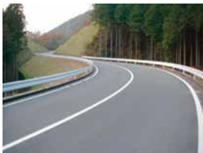
農林業用道路の整備（島根県江津市）
