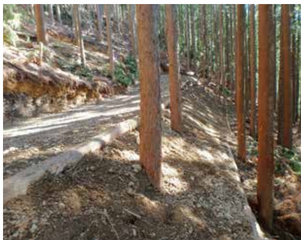
写真5 丸太組工法による作業道(静岡県島田市)
