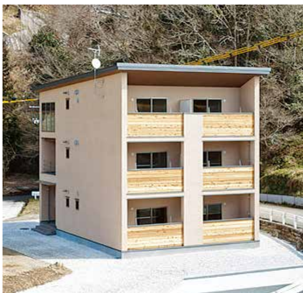
図4 国内初のスギCLTによる建築物 (銘建工業株式会社提供)
