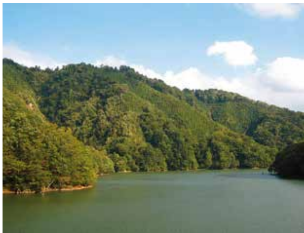
写真1 須田貝ダム湖と水源林造成事業地 （群馬県利根郡みなかみ町）
