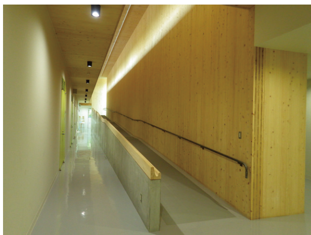
CLTを使った共同実験棟の内部
