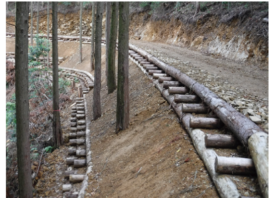
写真5 丸太組工法(のり留工)による作業道 (福岡県築上郡築上町)
