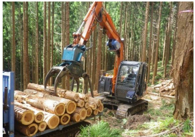
写真4 間伐材の搬出状況(福島県郡山市)
