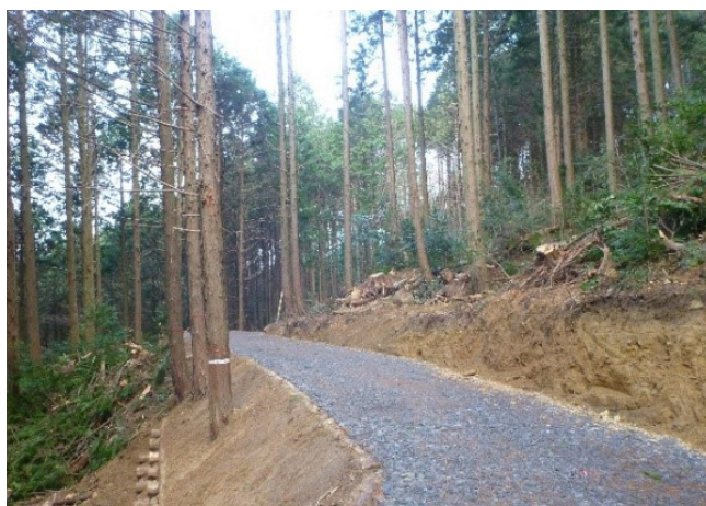
写真5 丸太組工法(のり留工)による作業道(佐賀県唐津市)
