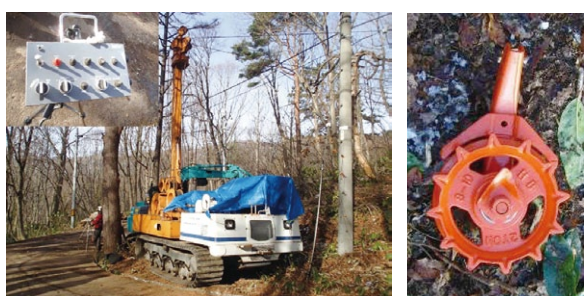
写真-1 使用したタワーヤーダ (I社TY-U4) とジグザグ滑車
