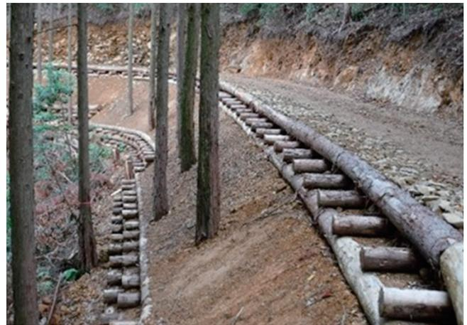
写真 10 丸太組工法(のり留工)による作業道(福岡県筑上郡筑上町)
