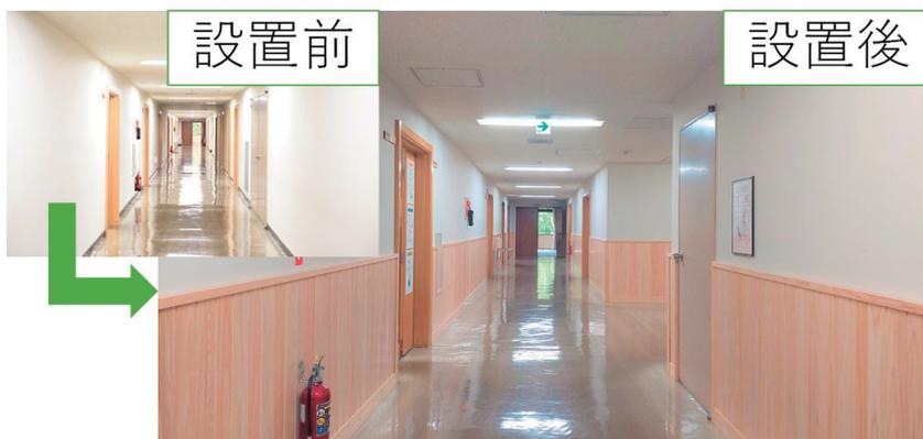
写真2 廊下壁面の腰壁としてヒノキを使用
