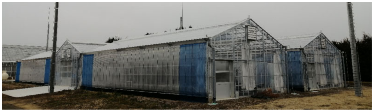
写真7 令和4年4月に建設された特定母樹等育成温室
