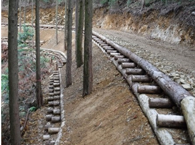
写真12 丸太組工法(のり留工)による作業道(福岡県築上郡築上町)
