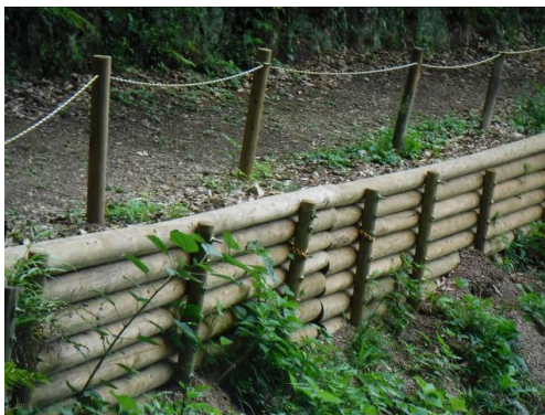
写真6 スギ間伐材の丸太を活用した土留め（多摩森林科学園）
