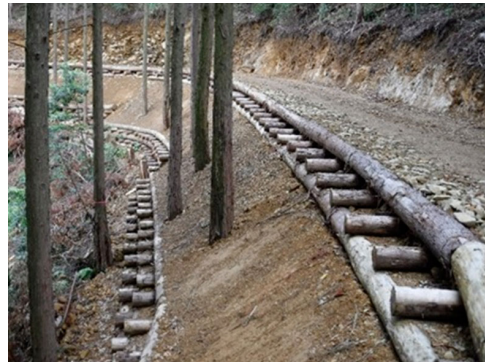
写真15 丸太組工法(のり留工)による作業道(福岡県築上郡築上町)
