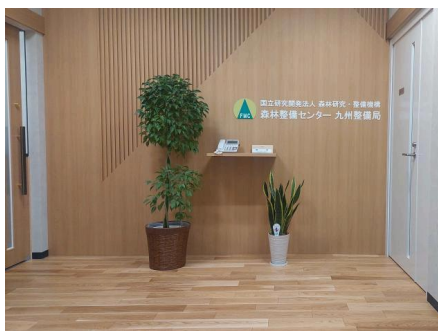
写真8 国産ナラ材を使用した受付フロア床板（九州整備局）
