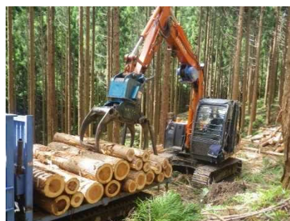
間伐材の搬出状況 (福島県郡山市)
