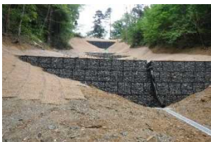
写真 3：多摩森林科学園災害復旧工事
