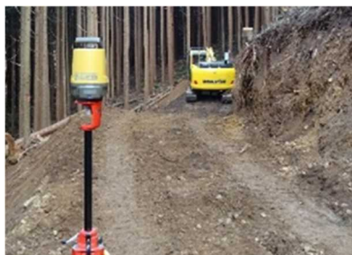
情報化施工による道づくり
