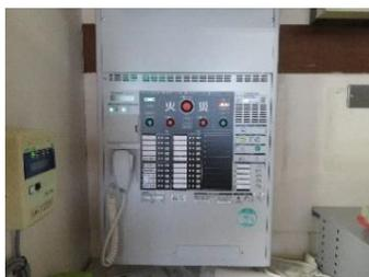
老朽化により動作不良を起こしていた非常放送設備及び自動火災報知設備を最新のものに更新。
