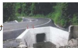
排水工の設置
