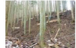
移動抑制対策(筋工)
