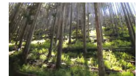
間伐・筋工の設置
