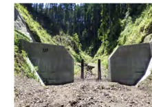
流木捕捉式治山ダム
