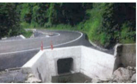
排水工の設置
