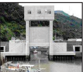
津波・高潮対策としての水門整備
