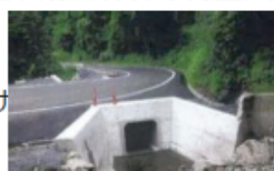
排水工の設置
