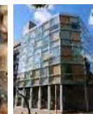
木造高層ビル
