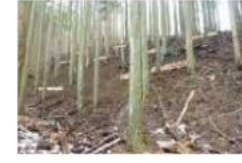
移動抑制対策(筋工)
