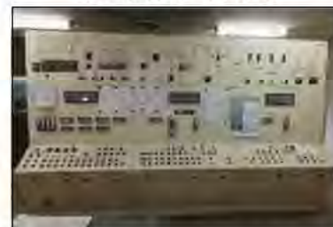
【実験廃水処理設備】
