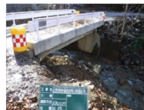
老朽化した林道橋の補修
