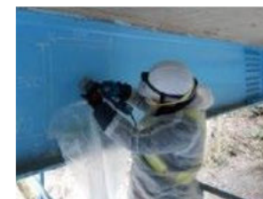
PCBを含む塗膜の剥離工事
