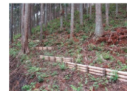
移動抑制対策(筋工)
