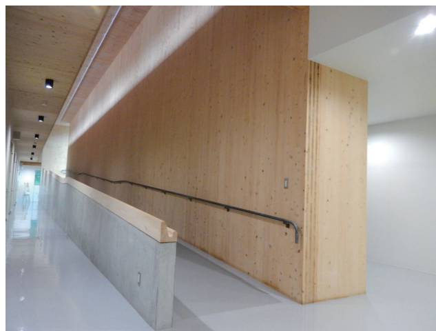
新しい木質材料 CLT を使った建物の見学
