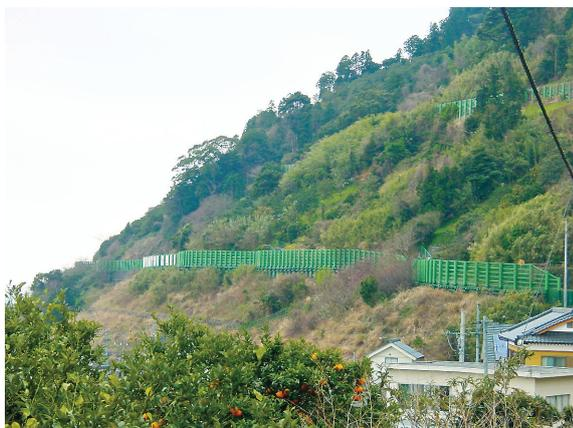
写真-3 地震による崩壊の抑制と落石防止を兼ねた対策工（斜面の上段と中段に見える緑のフェンス）
