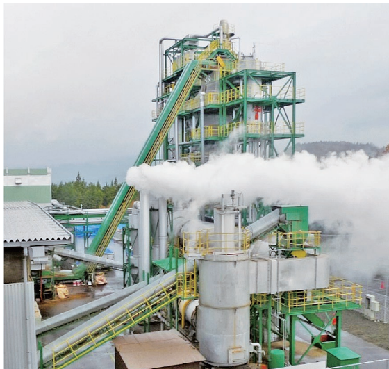
写真-1 木質バイオマス発電施設 (大分県日田市)
