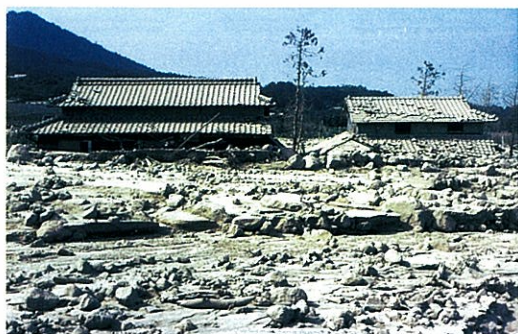
写真-7 土石流によって埋められた家屋
