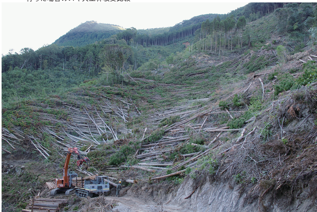
写真一 1 高性能林業機械を使用した皆伐現場 高性能林業機械をうまく活用して低コスト化を図るのも有効な手段
