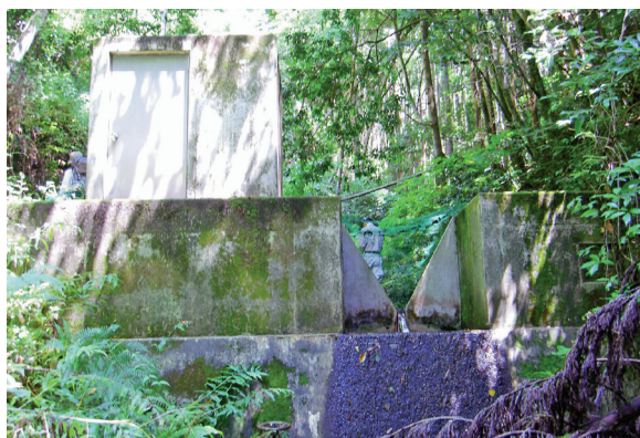
写真－１ 量水堰付近の状況
