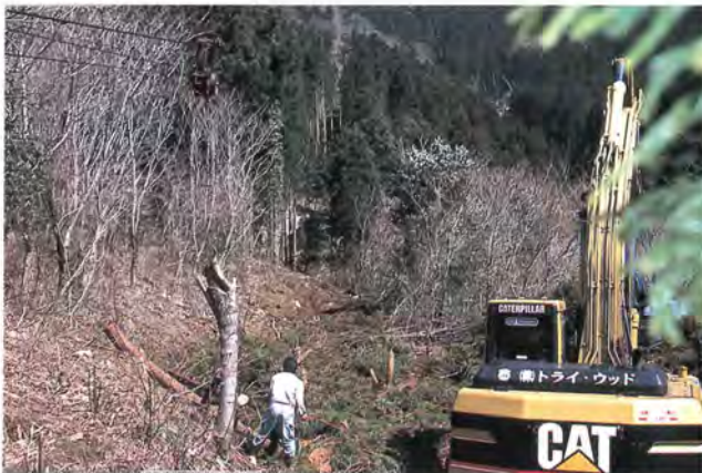
写真-3 土場に到着後の林木を搬器から荷下ろしする高性能林業機械オペレータ
