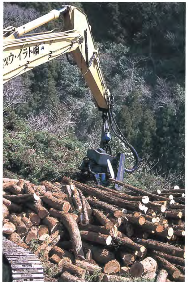
写真-4 高性能林業機械が枝払い・玉切り・極積み作業をこなす
