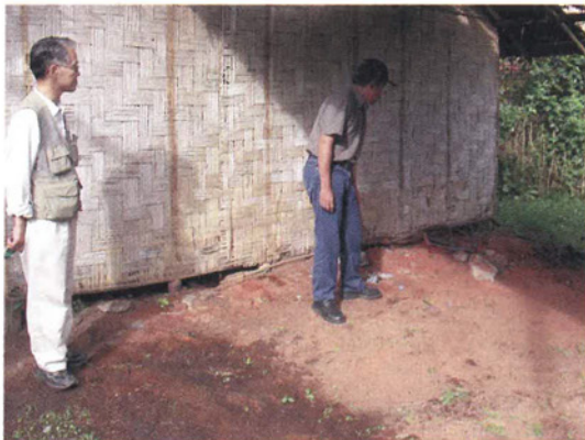
写真－３ 栽培舎の外側の様子 (壁はタケの皮を編んだもの)
